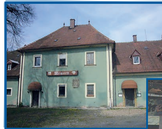
Sanierung des alten Meierhofs (ehem. „Memory“)
